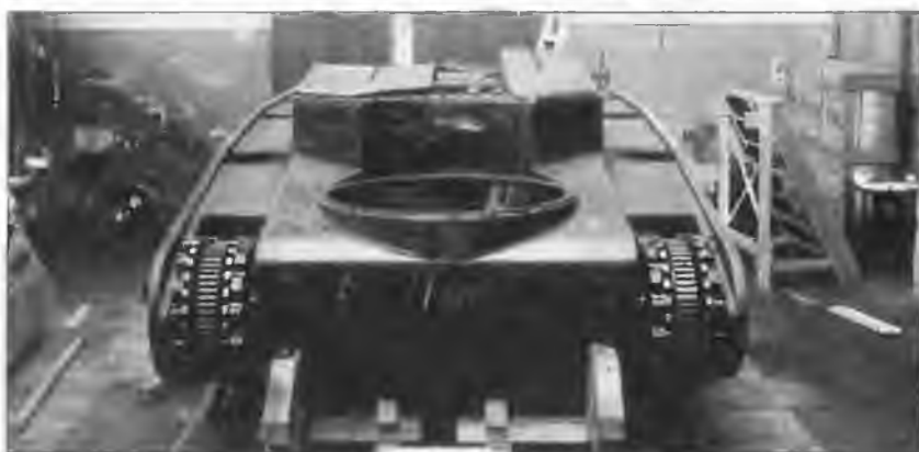
Вид на шасси «гросстрактора» Daimler-Benz сзади сверху. Хорошо видно отверстие для погона кормовой башни
