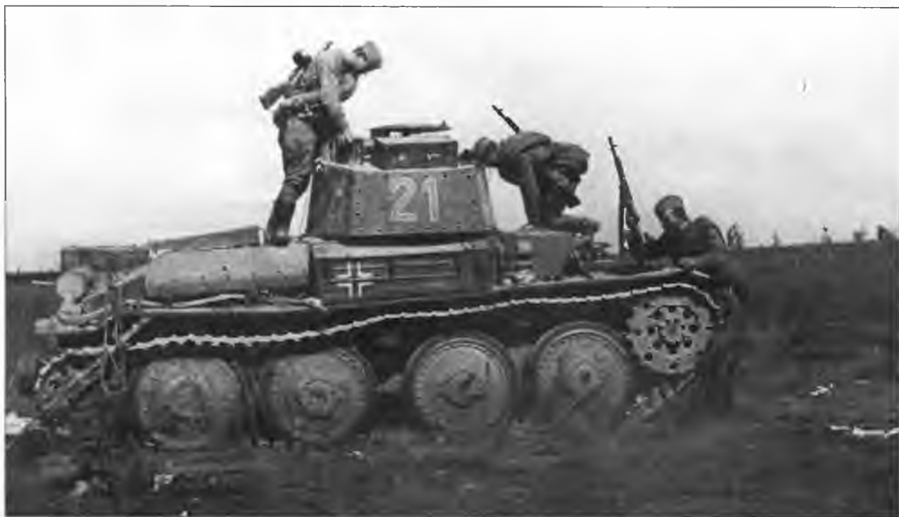
Красноармейцы осматривают подбитый танк Pz.38(t) Ausf.G из состава 20-й танковой дивизии. Обращает на себя внимание ствол пушки вражеского танка, пробитый советским снарядом! Западный фронт, июль 1941 года
