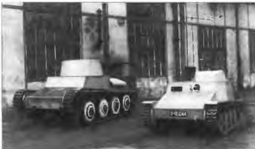
Прототипы танка TNH (слева) и танкетки AH-IV (справа) во дворе фирмы CKD. Сентябрь 1935 года. Обе машины изготовлены из простой стали
