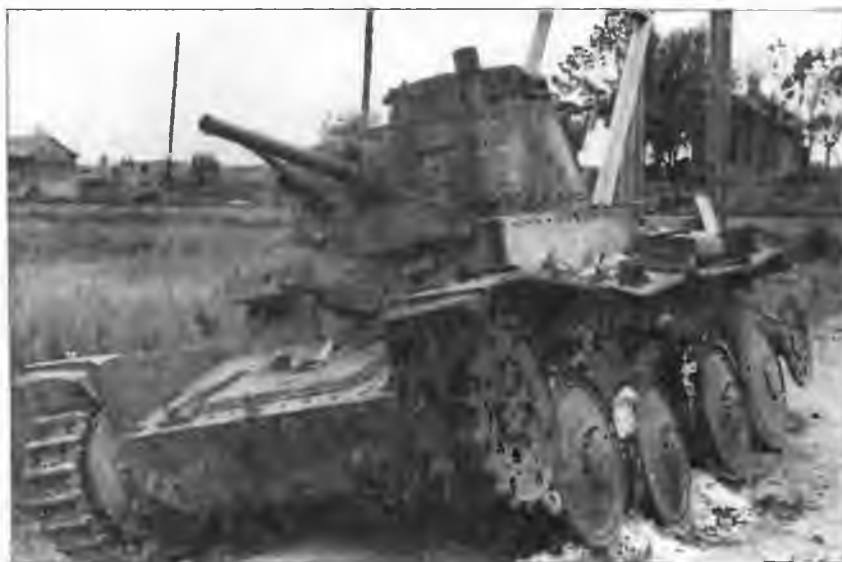
Pz.38(t) Ausf.A (либо Ausf.B ранних выпусков), подбитый советскими войсками в Белоруссии, 1941 год. Эту машину отличают антенный ввод чехословацкого типа и амбразура прицела раннего образца с одним отверстием
