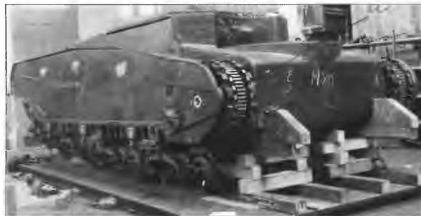
Сборка «гросстрактора» Daimler-Benz в Унтерлюсе. Январь 1929 года. Хорошо видны элементы ходовой части: тележки с опорными катками и ведущее колесо
