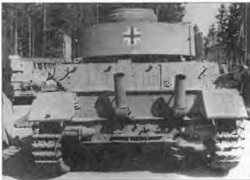
Вид сзади на Pz.IV Ausf.J, изготовленный заводом Nibelungen в августе-сентябре 1944 года. Хорошо видны характерные выхлопные патрубки с пламегасителями
