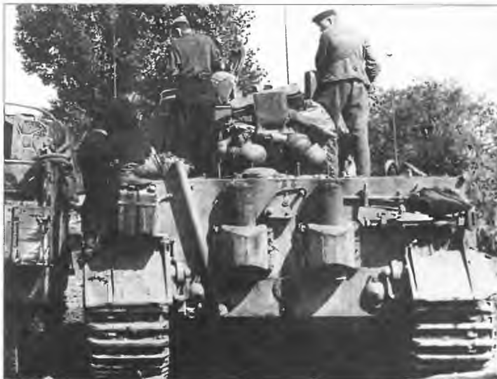
Командирский «Тигр» на Восточном фронте. Операция «Цитадель», лето 1943 года. Хорошо видна дополнительная антенна на башне и футляр для ее хранения, размещенный на кормовом листе корпуса
