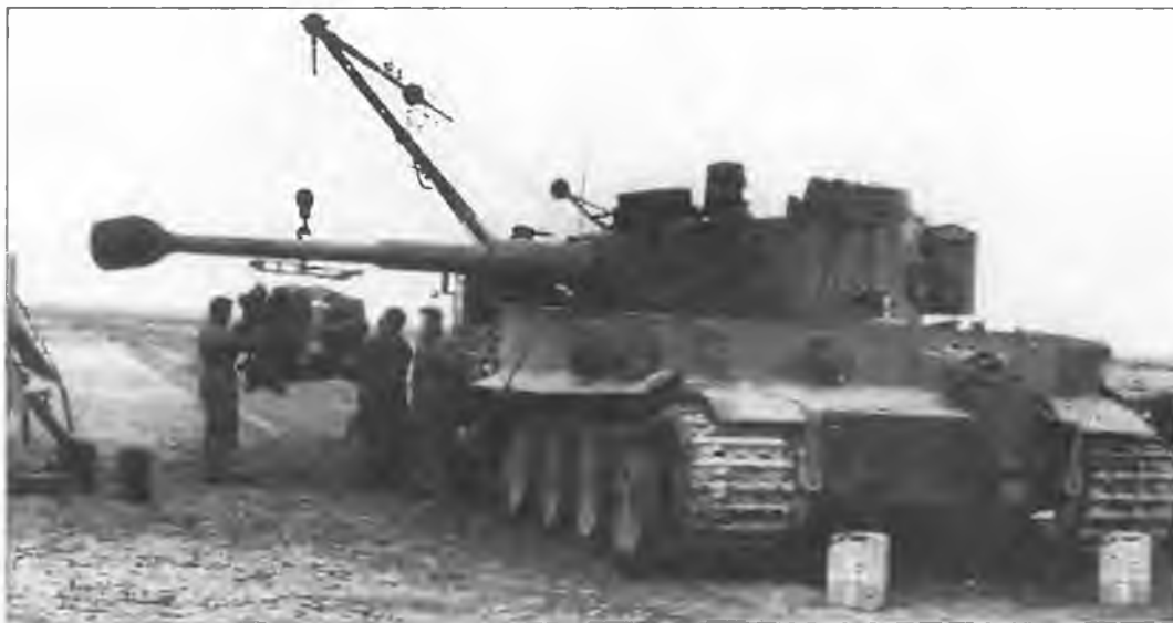
Демонтаж двигателя с танка в полевых условиях. Тунис, февраль 1943 года
