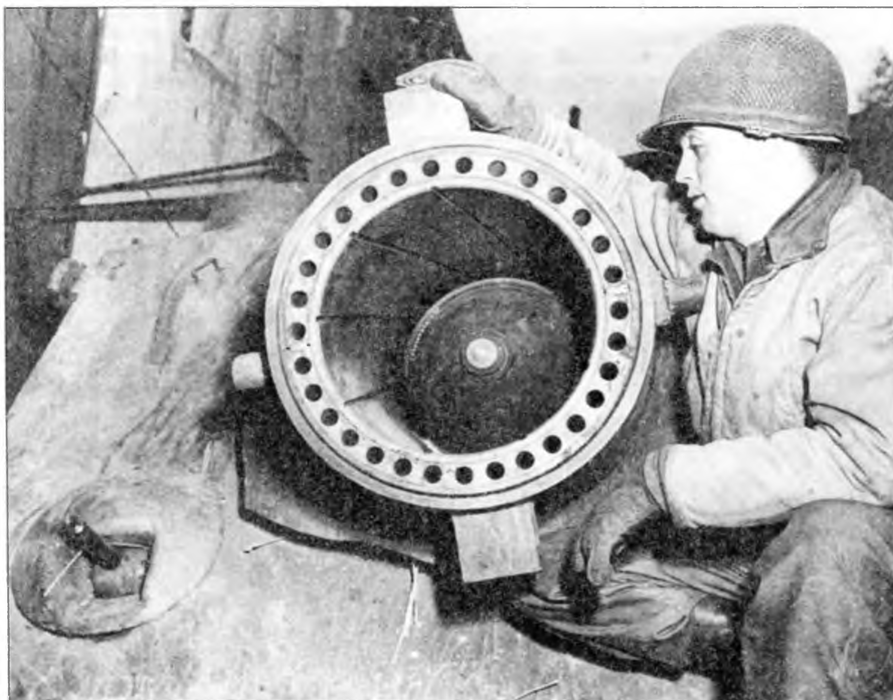
Американский солдат осматривает ствол бомбомета. Хорошо видны отверстия для отвода газов и ракета в стволе бомбомета
