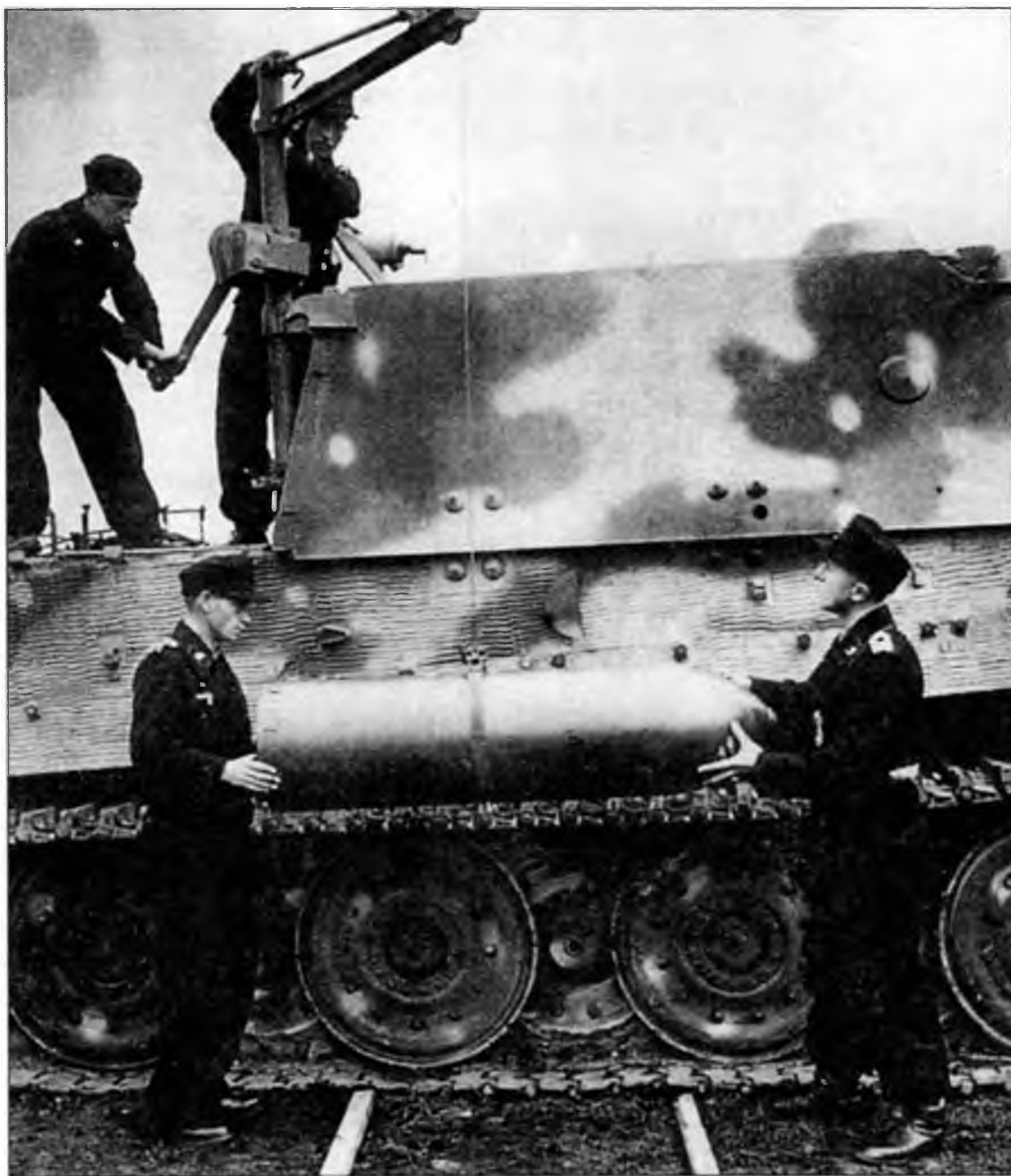
При загрузке боеприпасов в «Штурмтигр» ракеты поднимались с помощью крана
