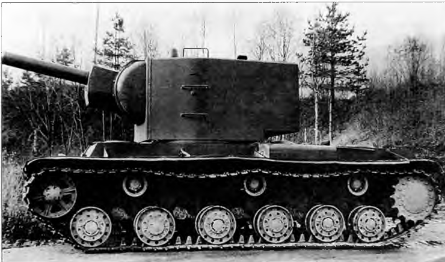
Танк КВ № У-7 с первым образцом «пониженной» башни. Сентябрь 1940 года (фото слева и внизу). Крышка люка для монтажа и демонтажа орудия у этой башни выполнялась откидной на петлях. Слева от люка видна заваренная амбразура кормового пулемета ДТ
