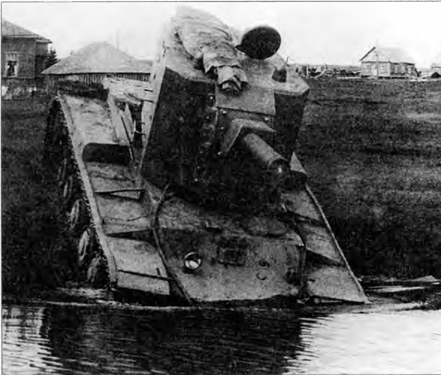
Танк КВ № У-1 пре- одолевает брод во время испытаний. Район Ленинграда, июнь 1940 года
