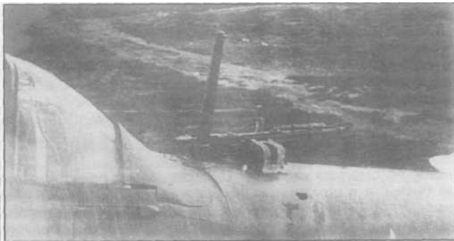
Кормовая дистанционная установка с одним пулеметом УБ одноместного Ил-2 АМ-38 (завод № 18). Государственные испытания, февраль 1942 г.
