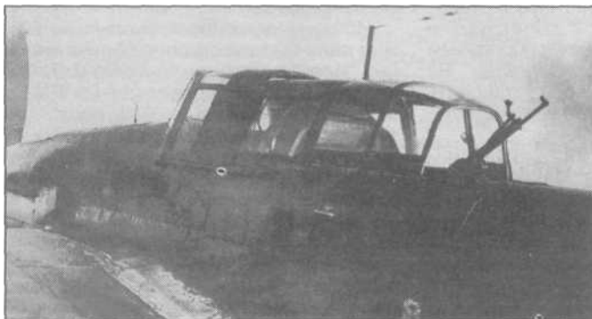
Ил-2 АМ-38 с пулеметом ШКАС. Государственные испытания, 1942 г.
