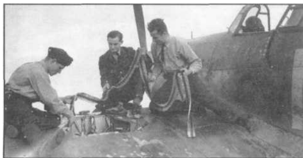
Перезарядка бортового оружия «Харрикейна» из 310-й эскадрильи. Каждый из восьми пулеметов «Браунинг» заряжен лентой из 300 патронов, которой хватало примерно на 15 секунд непрерывного огня.
