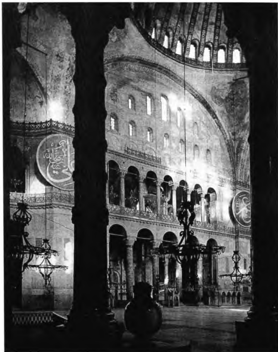
Рис. 5.42. Грандиозный храм Святой Софии в Константинополе. Огромный купол диаметром 31,5 метра поддерживается сложной системой полукуполов. Взято из [643:2], с. 41
