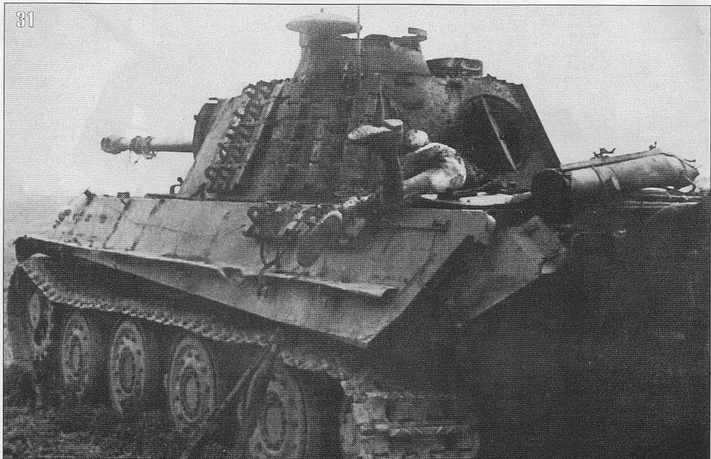
30, 31. Танк Pz.V «Panther» Ausf. G из состава 21-й танковой дивизии вермахта, подбитый в районе Коттбуса 19 апреля 1945 года. Машина имеет катки с внутренней амортизацией, на лобовом листе виден заводской номер танка 127039, на корме лежит сгоревший член экипажа (АСКМ).
