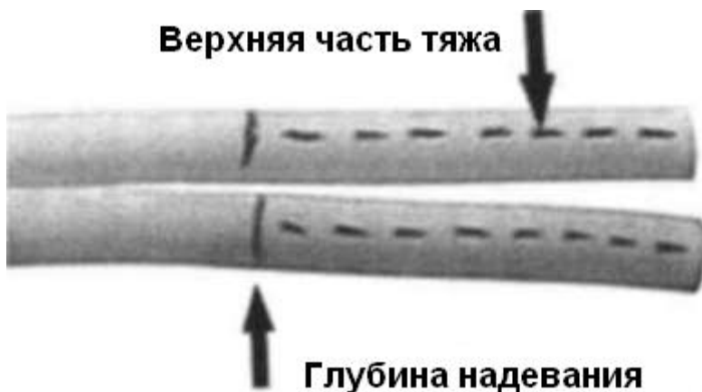
Рисунок 2-8. Пометьте верхнюю сторону каждого тяжа.
