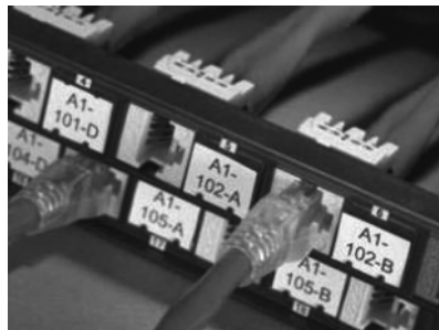
Рис. 7.4. Схема двухуровневого расположения розеток и элементов маркировки на наборных панелях
