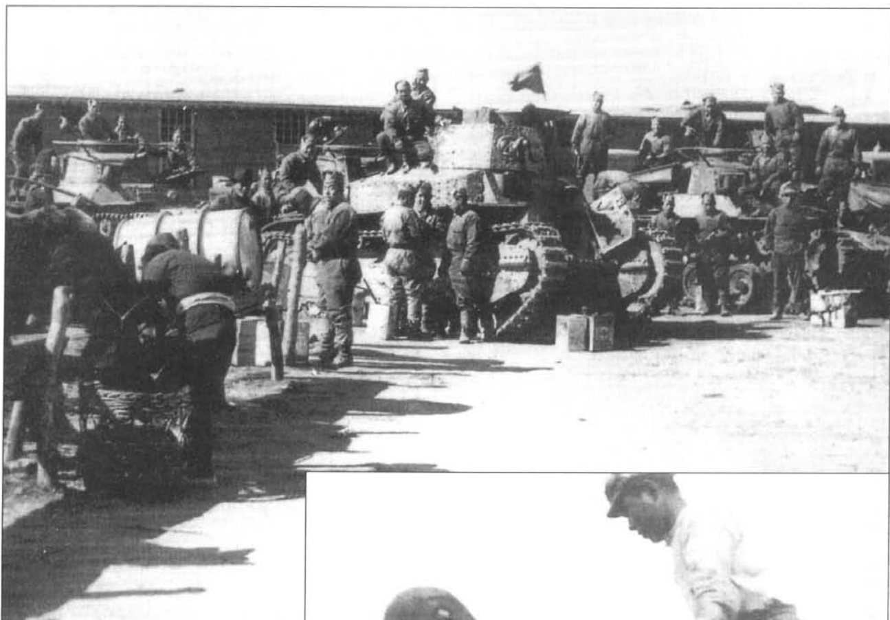
Заправка средних танков «тип 89» («2594») и «тип 97 Чи-ха», Китай. Обратите внимание на стоящие перед танками прямоугольные «банки» емкостью 5 галлонов - предшественницы канистр.
