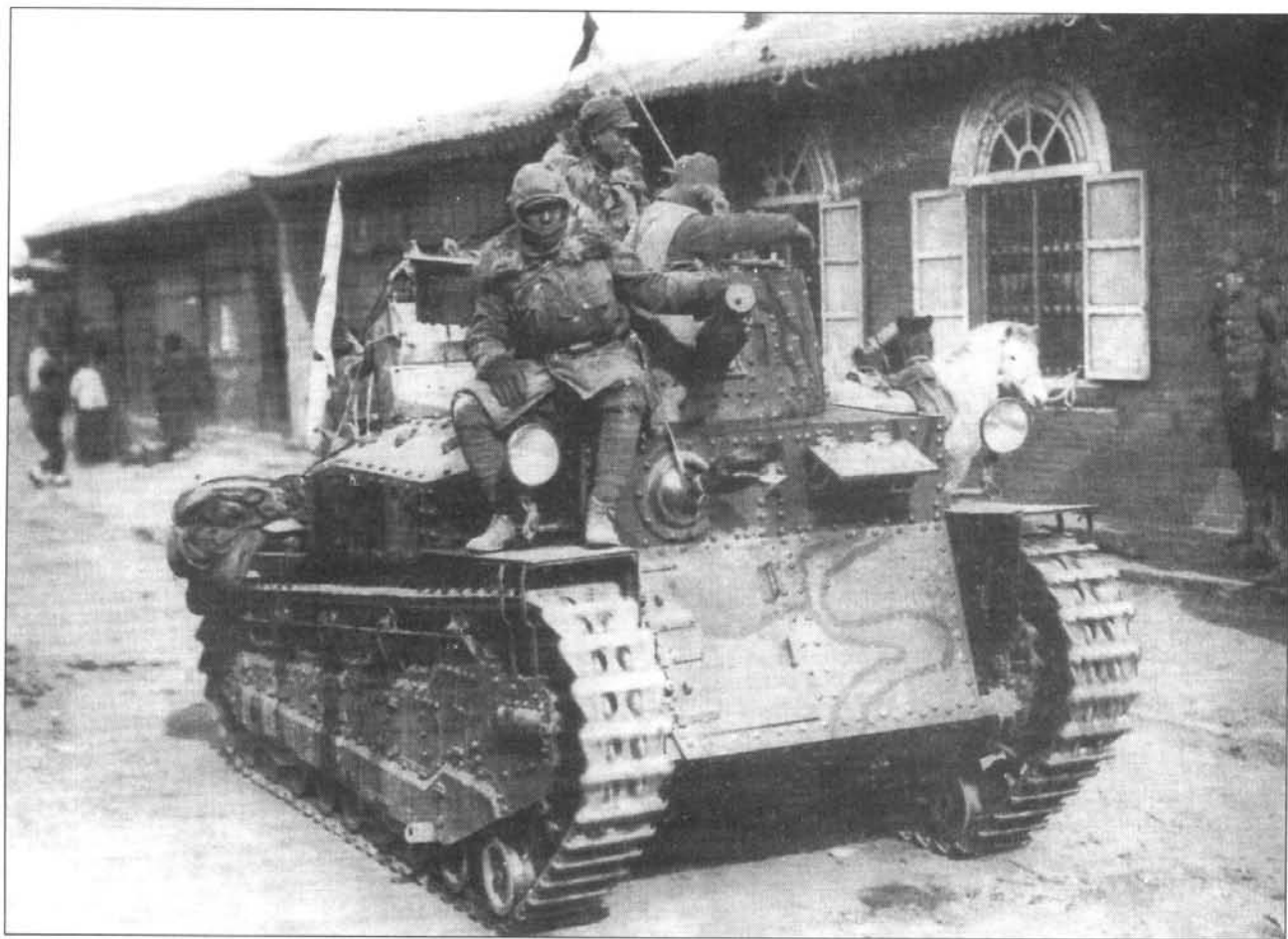
Танк «тип 89А» ранней постройки с новыми траками, Китай. Камуфляжная окраска типична для середины 30-х годов. Ствол пулемета закрыт чехлом.
