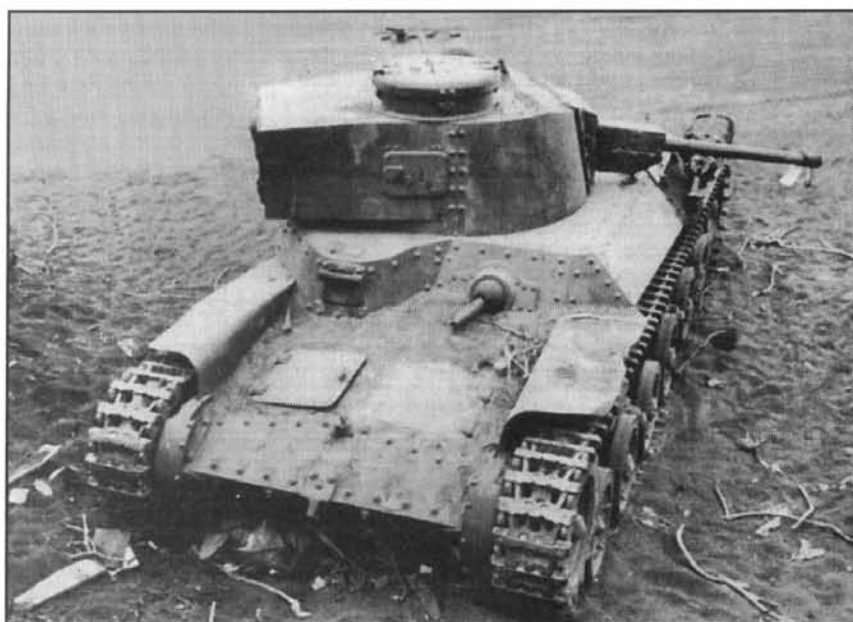
Средний танк «тип 97 Шинхото Чи-ха» из 26-го танкового полка подполковника Ниски. Машина подбита на Иводзиме, снимок сделан 30 апреля 1945 г. Обратите внимание на коммуникационный лючок в правом борту башни, в лючке имеется закрытая бронезаслонкой амбразура для стрельбы из пистолета. Интересная особенность данной машины - на ней вообще нет наблюдательного прибора командира, ни в створке верхнего люка, ни в крыше башни.
