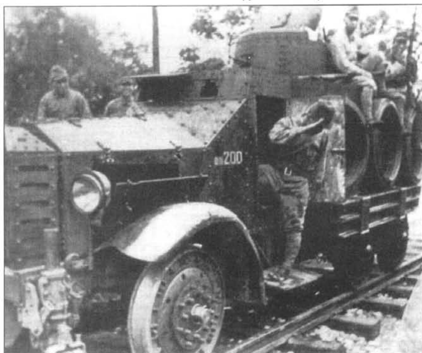
Бронедрезина - броневомобиль «тип 93 Сумида» на железнодорожном ходу. В передней части машины виден один из четырех встроенных домкратов, облегчающих перестановку с «шоссейного» на железнодорожный ход.
