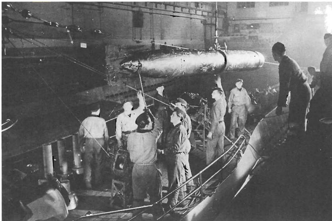
Погрузка торпеды на подводную лодку типа VIIC в укрытии для лодок на французском побережье Атлантики. По цензурным соображениям с фотографии удален гребной винт и рулевой механизм
