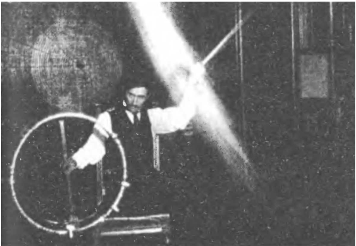
Тесла в своей лаборатории на Хьюстон-стрит пропускает 500 000 вольт сквозь свое тело, чтобы зажечь беспроводную флуоресцентную лампу. 1898 г.
